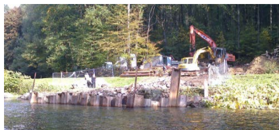
Abb. 6: Pegel Göritz im Bau.
