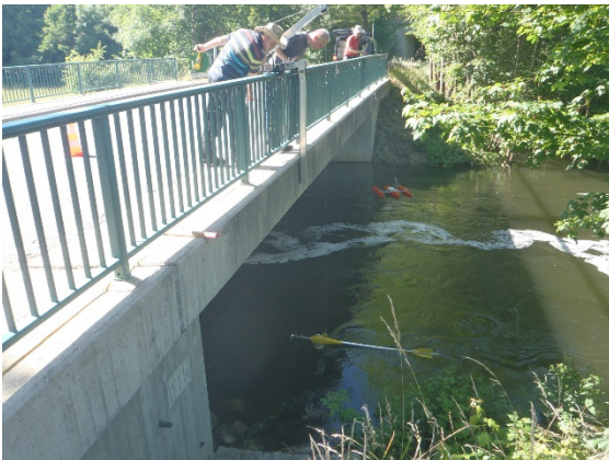
Abb. 8: Eichmessung am Pegel Magwitz für den neuen Schieber der Talsperre Pirk.
