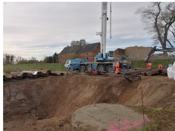
Abb. 19: Aushub Baufeld und Setzen der Spundwände.
