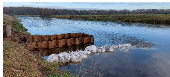
Abb. 20: während der Baumaßnahme.
