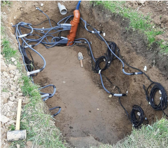
Abb. 17: Neue Sonden im geöffneten Schurf der Station Hilbersdorf.
