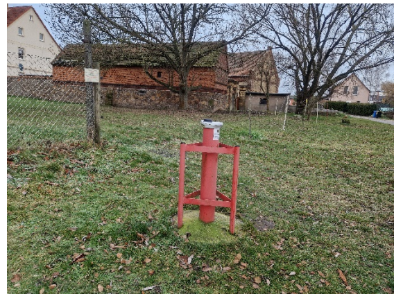
Abb. 12: Grundwassermessstelle mit neu ausgestatteter DFÜ.
