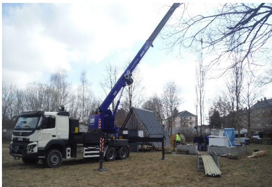
Abb. 13: Einbau der neuen Steigleitung an der Grubenwassermessstelle Oelsnitz/Erzgebirge.
