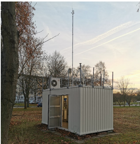
Abb. 5: neu errichteter Container der Luftgütemessstation Zittau.
