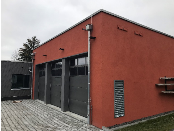
Abb. 3: Nistkästen für Mauersegler in der Fassade des neuen Betriebsgebäudes Brandis.
